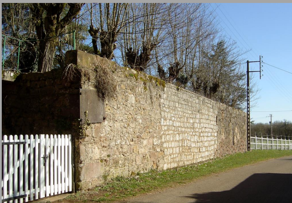
▲ le mur des trémies à Ferals :
