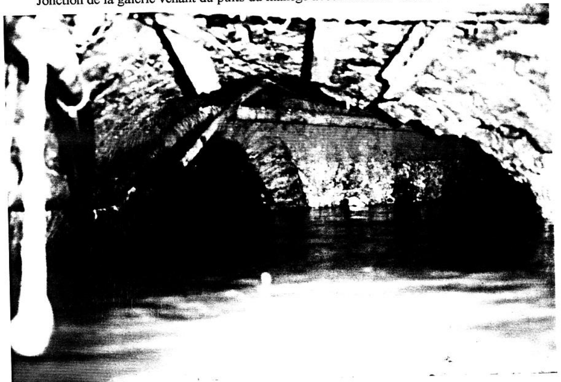
Jonction de la galerie venant du puits du manège avec le travers-banc 518. Août 1984.
