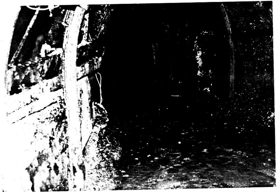
Travers-banc niveau 519. Mai 1992. Essais de réouverture. (Photo: JC Delhomme)
